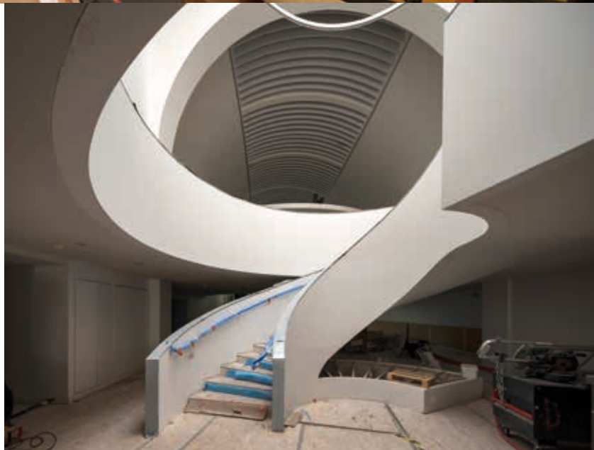
Musée national de la Marine, Paris. Chantier de rénovation. Palais de Chaillot. Escalier vers la mezzanine en galerie Davioud. 04/04/2023 ; h2o architectes et Snøhetta. © Patrick Tourneboeuf/OPPIC/Tendance Floue
