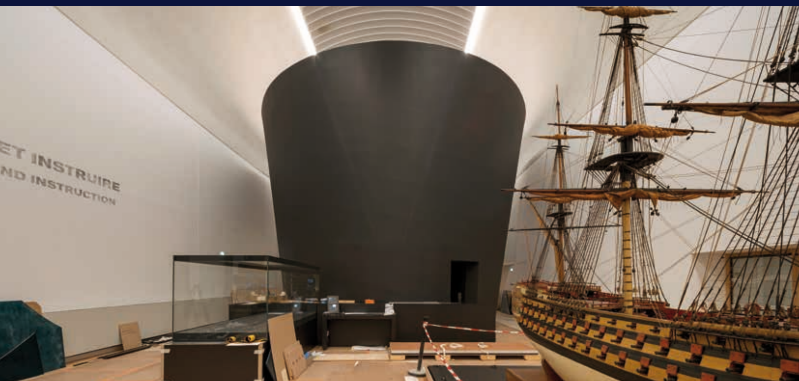
Musée national de la Marine, Paris. Chantier de rénovation. Palais de Chaillot. Galerie Davioud, rez-de-chaussée. Espace d'exposition permanente. h2o architectes et Snøhetta. Casson Mann. 06/10/2023 © Patrick Tourneboeuf/OPPIC/Tendance Floue
