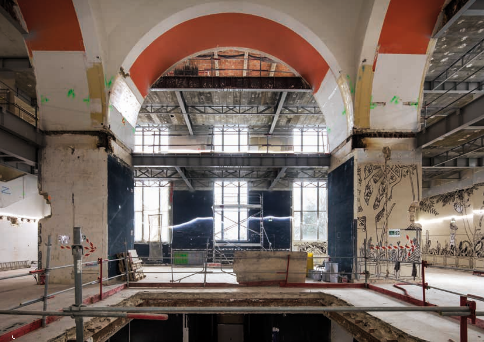
1_ Musée national de la Marine, Paris. Chantier de rénovation, Palais de Chaillot, Pavillon de tête ; Galerie Davioud. h2o architectes et Snohetta. © Patrick Tourneboeuf/OPPIC/Tendance Floue. 19/01/2021 2_Vue de la première mezzanine en Galerie Davioud. h2o architectes et Snohetta. 06/10/2023 © Patrick Tourneboeuf/OPPIC/Tendance Floue
